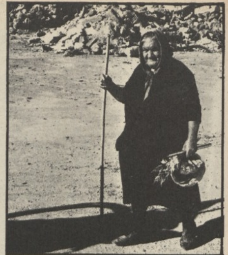
Le macerie di Montevago N. Tomassoli
