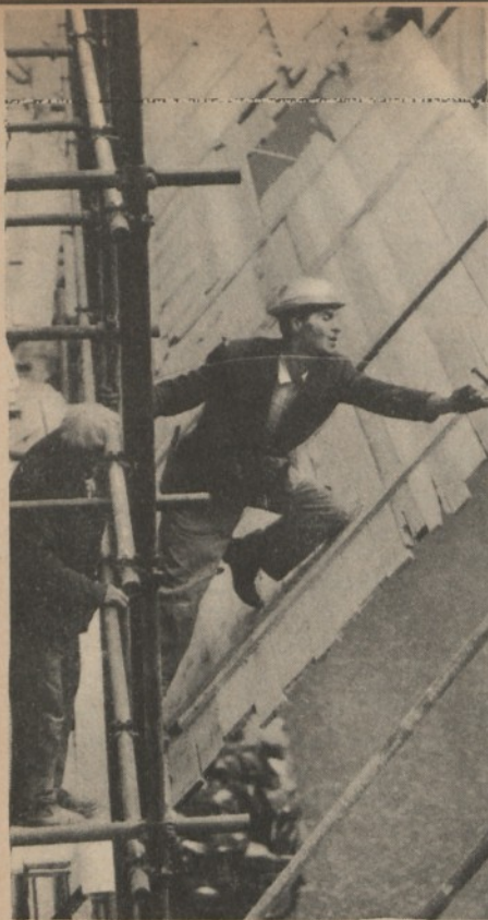
MILANO: restauro in via Spadari
