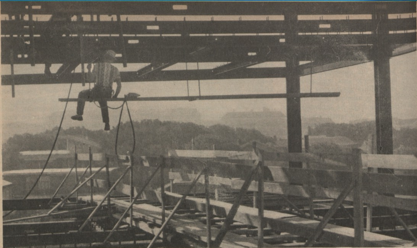
ROMA-EUR: il lavoro in cantiere
