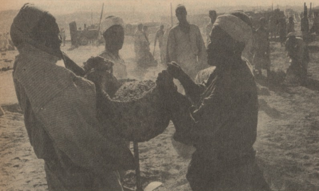
ASSUAN: operai egiziani al lavoro
